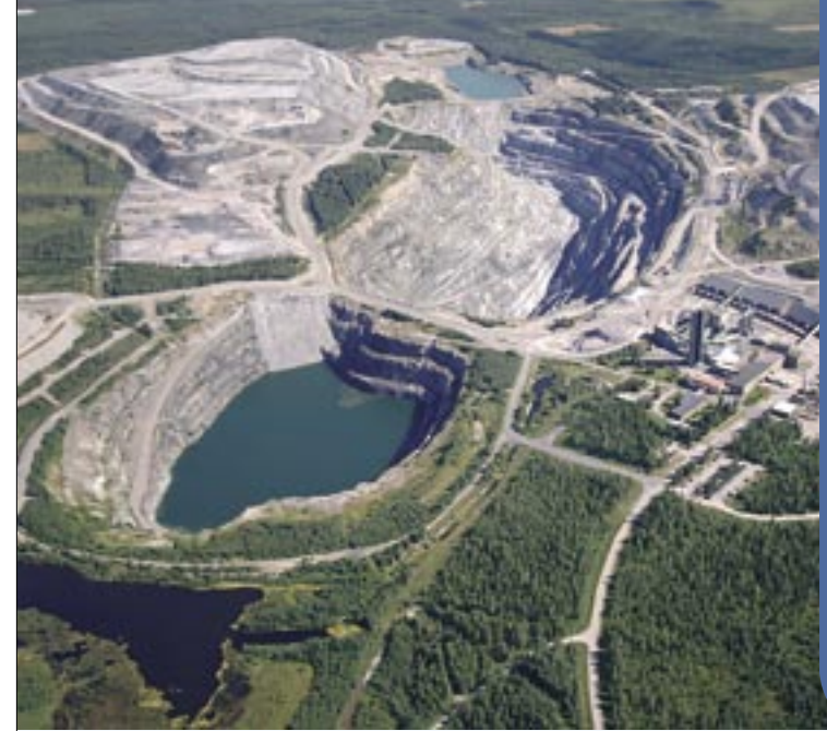
EU-maiden ainoalla kromikaivoksella Kemissä aloitettiin tunnelien louhinta Outokumpu Chrome Oy:lle.
