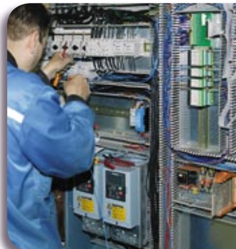
Här monteras automationsutrustning i YIT-verkstaden i Vanda
