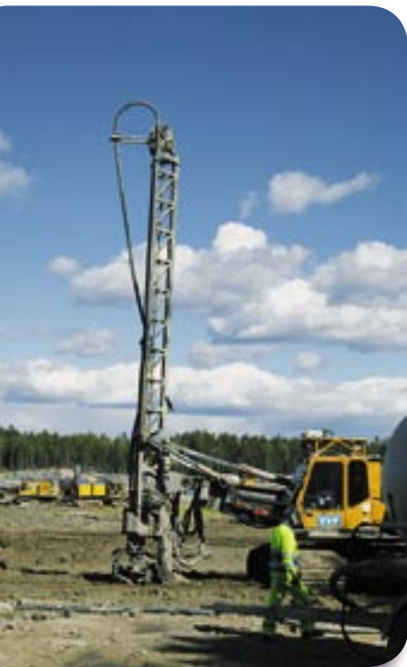
Finlands största markstabiliserings-uppdrag någonsin i hamnprojekt i Nordsjö Helsinki
