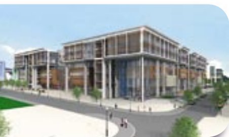
Handelshøiskolen BI får sin nya campus i Nydalen forsedd med elteknik och ClimaCeil samt datanätförbindelser, alla av YIT.
