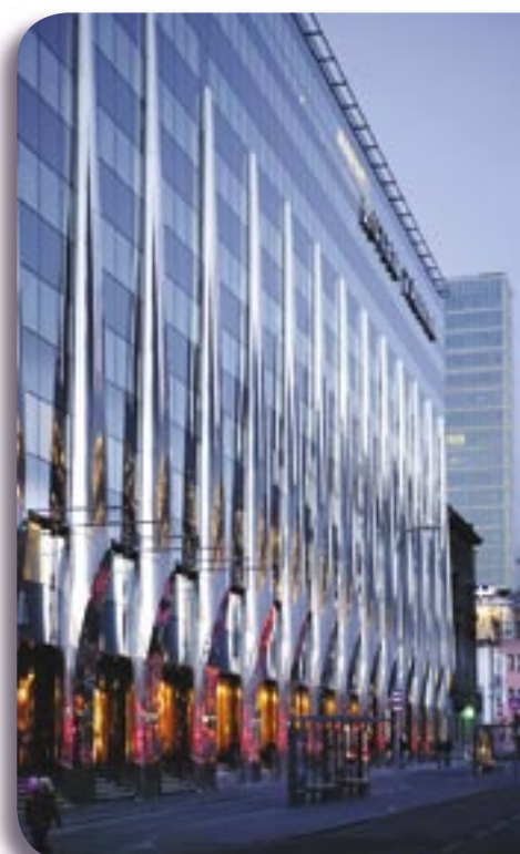
Eltekniska installationerna till nytt hotel Tallink i Estland.
